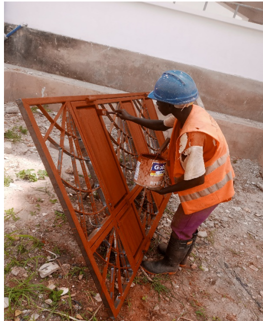
B11, MS double door primer painting work
